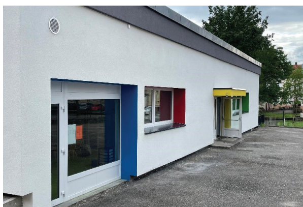
Après les travaux
